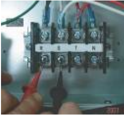
* Giriş voltajının ölçümü
