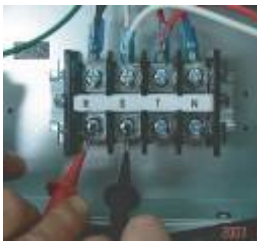
* Giriş voltajının ölçümü
